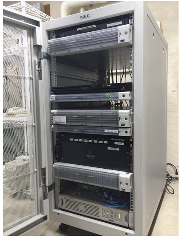
本社サーバー機器
