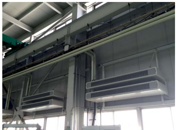
成形加工工場に増設されたファンコイル
