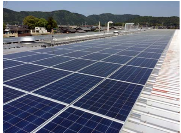
サービスアネックスの太陽光パネル
